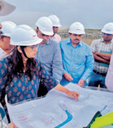
నిర్మాణ పనులను పరిశీలిస్తున్న పోర్టు మేనేజింగ్ డైరెక్టర్(ఎంఓ) మేకతోటి దయా సాగర్
